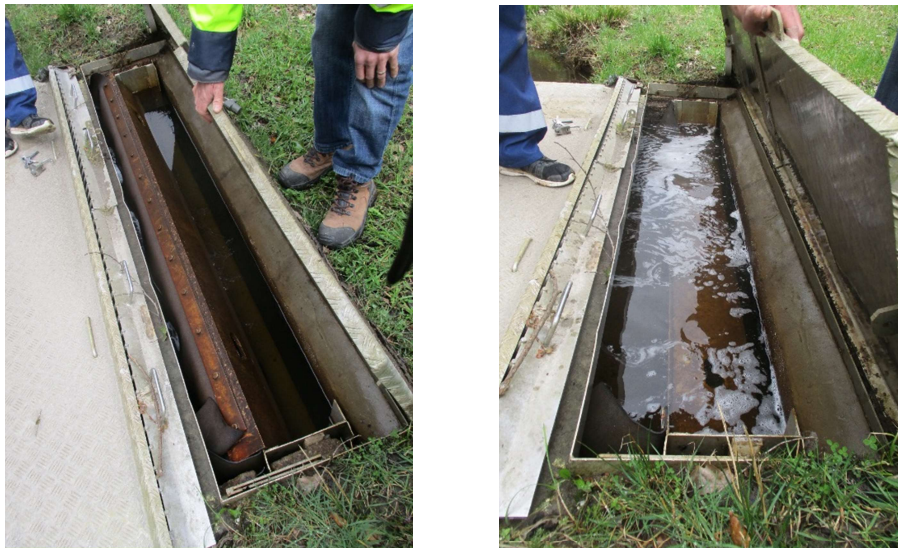
Figure 14 : Vue des batardeaux de l'ouvrage de prise d'eau (mars 2018)
